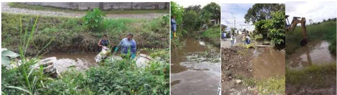
Trabajos de protección de la ribera para evitar la erosión provocada por el río Coca, debido a las condiciones climatológicas de la región
