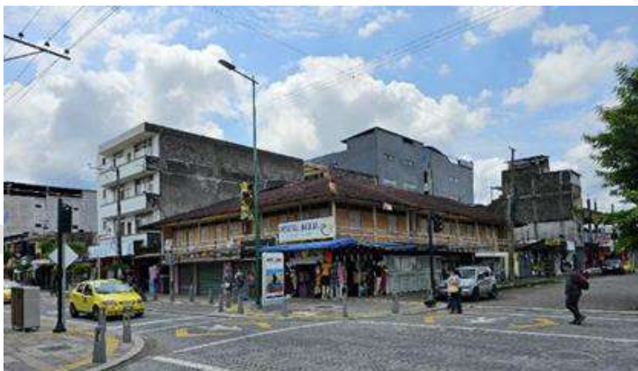
Fotografía 6: Edificación Napo y Guayaquil
