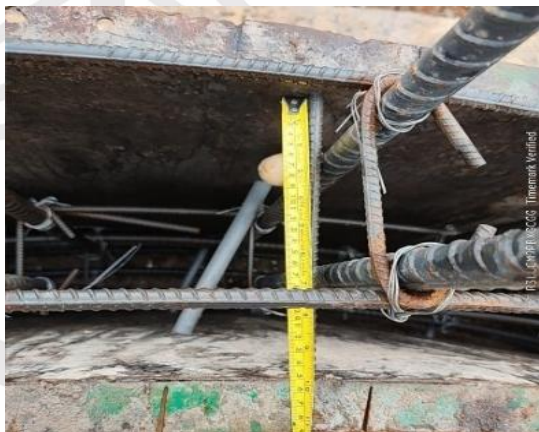
VERIFICACION DE MEDIDAS EN TANQUE ELEVADO
