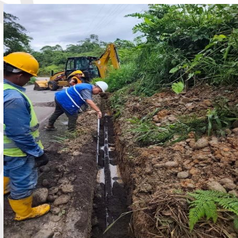
MEDICION DE ALTURA DE ZANJA
