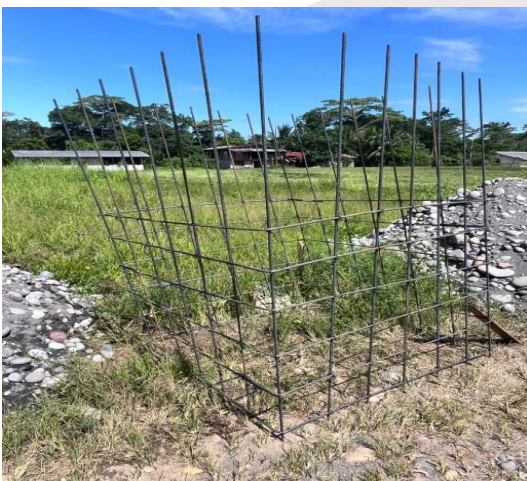
ARMADO DE ACERO EN CAJA DE VALVULAS
