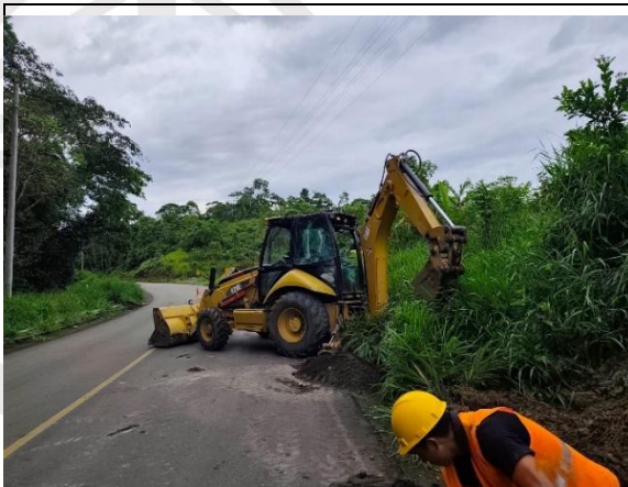
EXCAVACION A MAQUINA EN ZANJA
